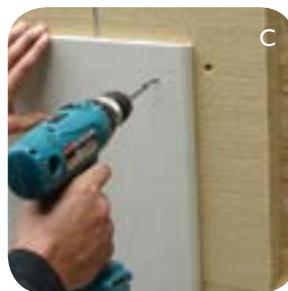
A Befestigung GUTEX Thermoinstal®
